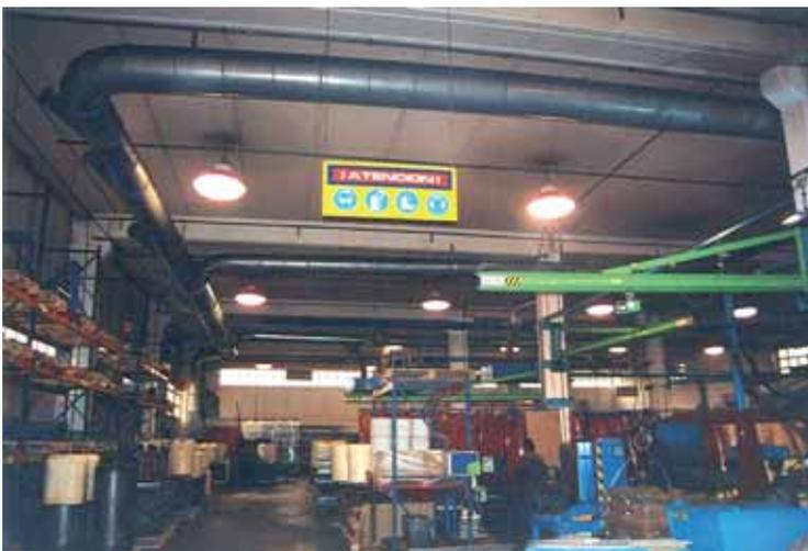
**Sistema de ventilación mecánica en una nave de soldadura.**
