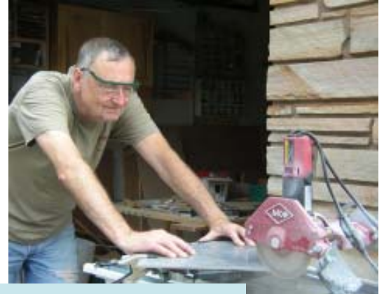
Un obrero de construcción usa una sierra de corte húmedo para cortar una baldosa cerámica de sílice.
