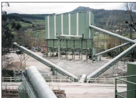
Vista general de una planta con silos carenados y cintas con capotajes autoportantes de chapa
