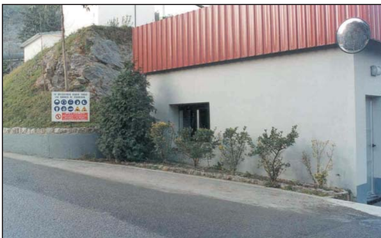
La limpieza de los accesos muestra si la empresa está concienciada del problema del polvo
