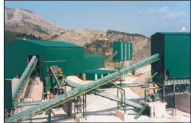
*Planta de tratamiento carenada y cintas con capotaaje de lona*
