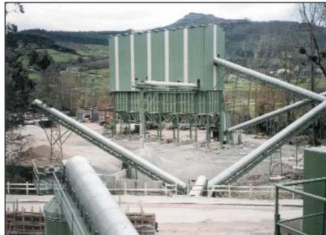
*Vista general de una planta con silos carenados y cintas con capotajes autoportantes de chapa*
