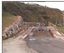
*Piscinas para lavado de ruedas. A la izquierda, arco de riego para la carga*
