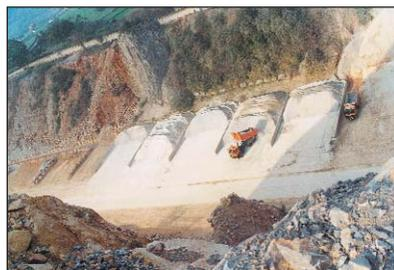
Protección de un acopio de finos con pantalla cortavientos
