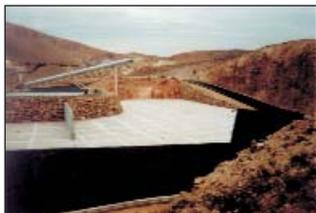
Área de acopios: soleras de hormigón y asfalto de áreas de tránsito
