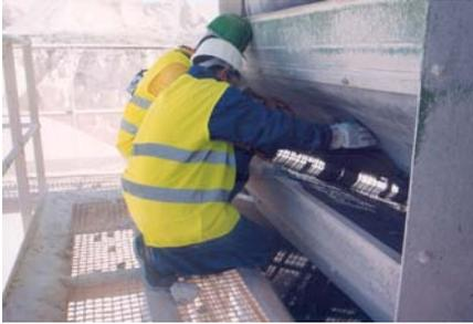
**Enclavar los equipos** permite realizar un **mantenimiento más seguro**. Impides que puedan **ponerse en movimiento** por sorpresa
